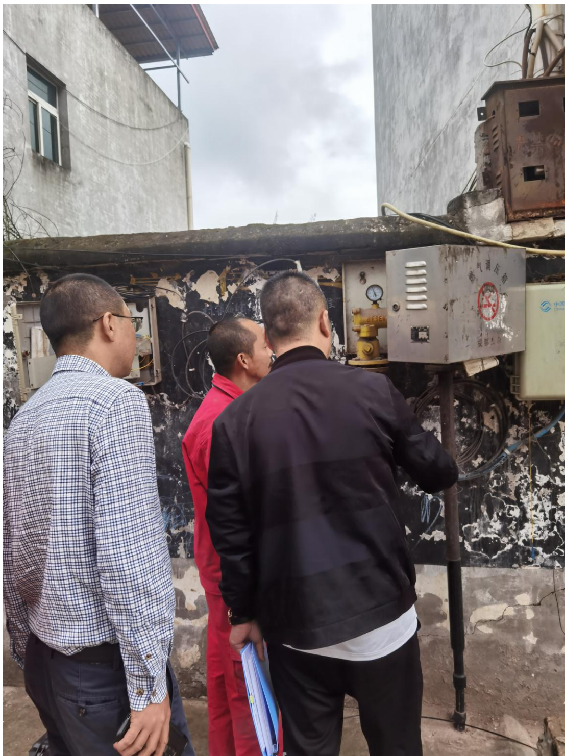
检查供气调压情况
