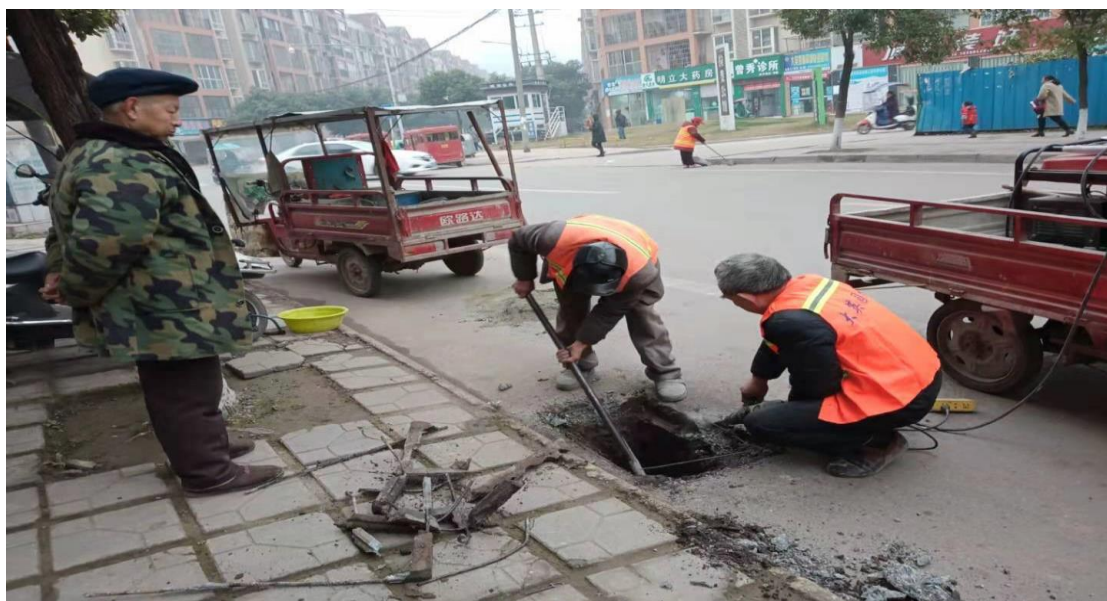
雨篦破损更换
