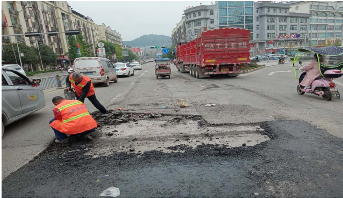
维修沥青路面
